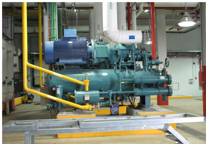
Şəkil 1. Aşağı temperaturlu kondensasiya qurğusu.
